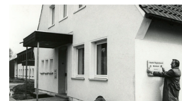
Umbau am Gutshof Wiggighausen
